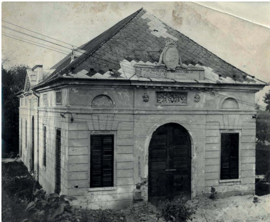
Obr. 4: Hlavný vstup do empírového divadla pred rekonštrukciou, okolo roku 1955. Zdroj: Fotoarchív Vlastivedného múzea v Hlohovci.
